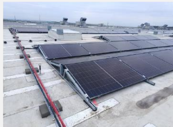
[ 태양광 패널 설치 ]
