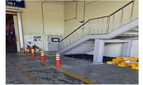
[입고장 보행자 통로 안전봉 설치]
